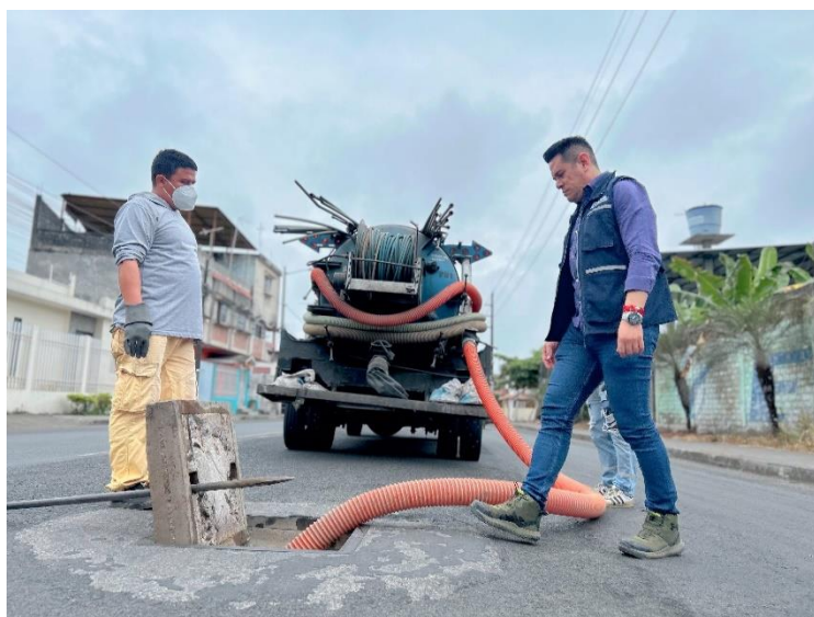
En los recorridos diarios que realizamos, socializamos con nuestro personal para supervisar los trabajos que se ejecutan en beneficio de la ciudadanía.
